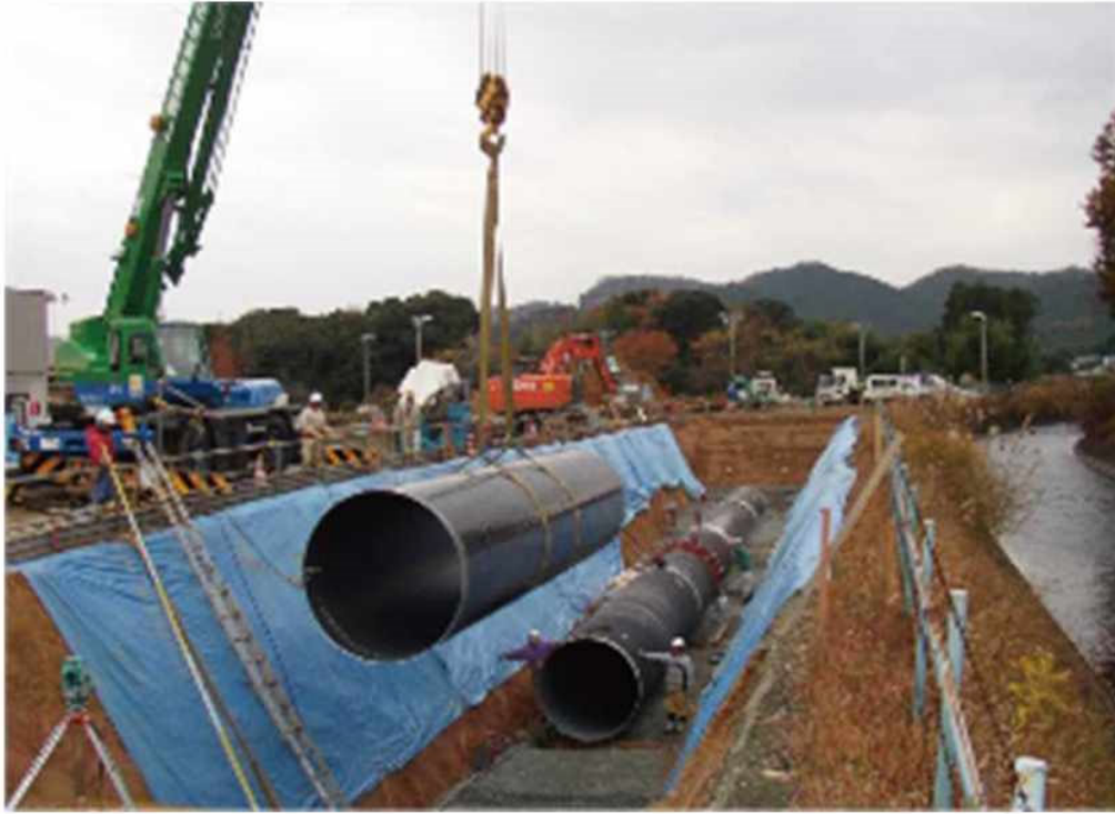
バイパス水路設置(豊川用水二期事業)
