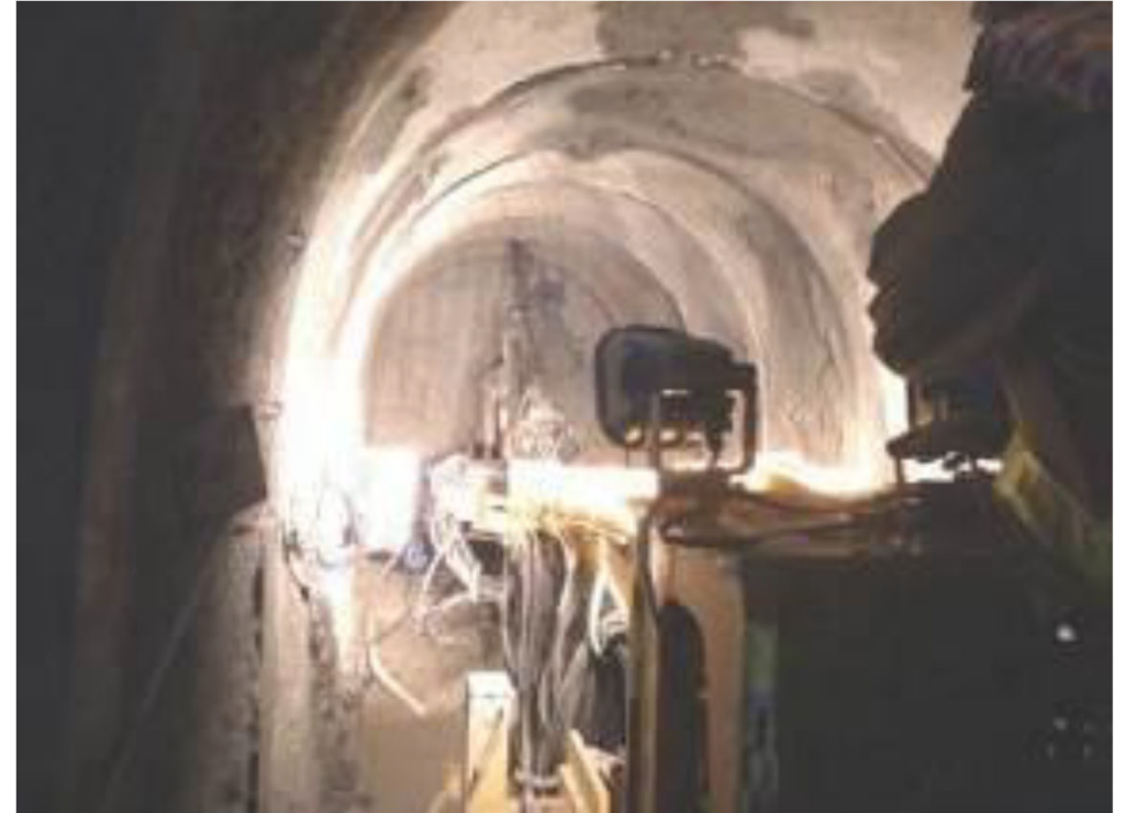
併設水路トンネル掘削(豊川用水二期事業)
