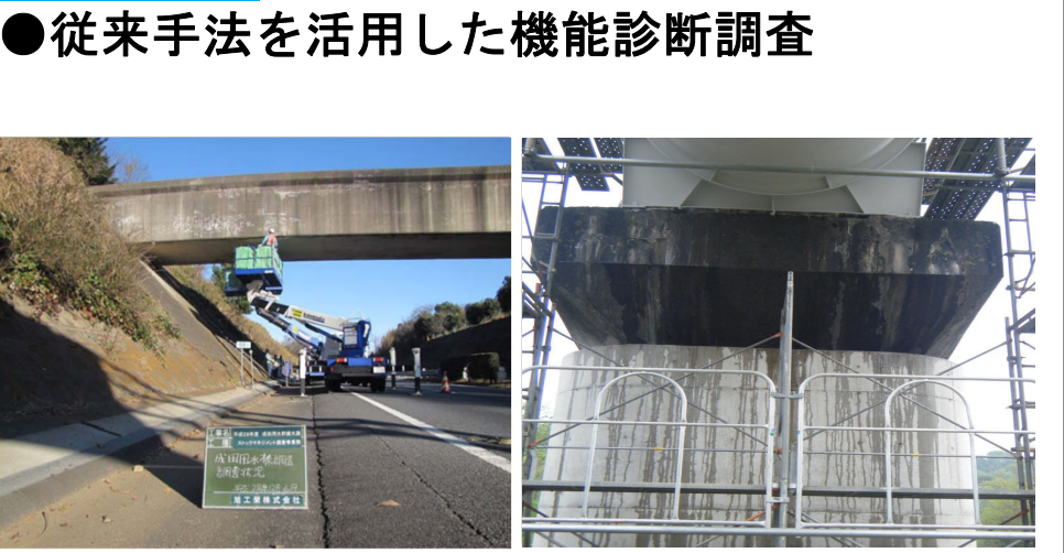
点検車、足場等の仮設を用いた目視点検
