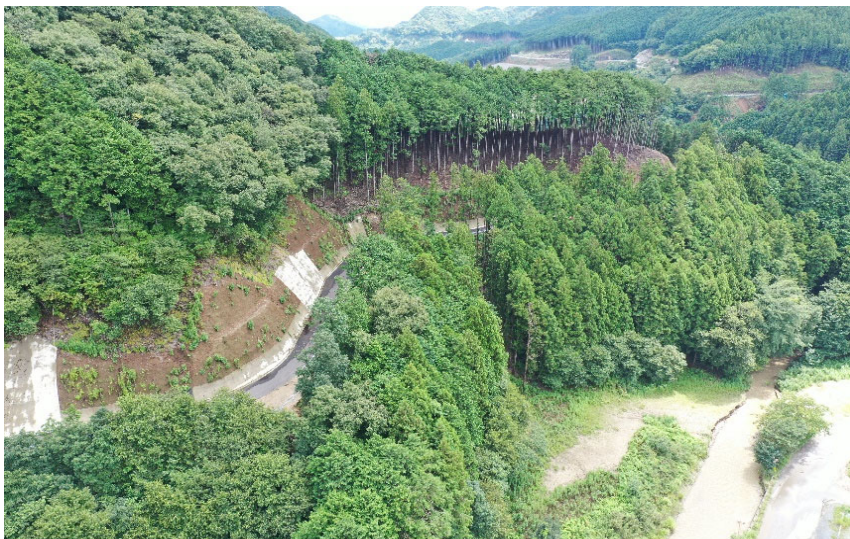
図-7 UAVによる付替林道被災状況確認
