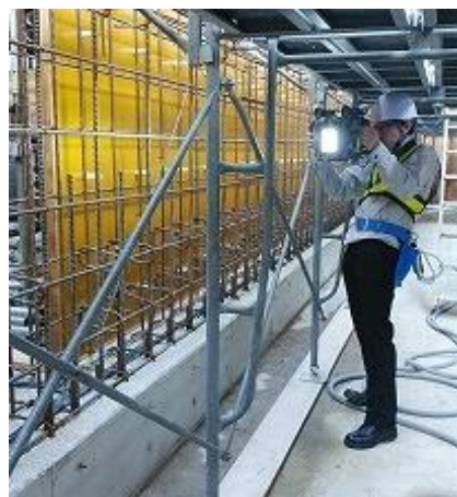
開削トンネル
