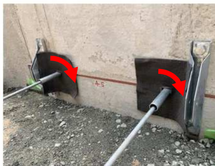
⑨ トルク鋼管の本締め ⑩ 壁面際の充填（以降通常施工と同様）
