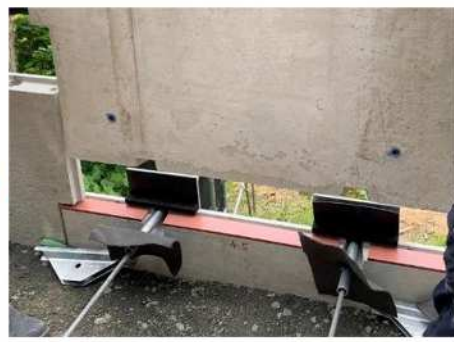
⑦ 上側壁面材の設置、固定 ⑧ 撒き出し、敷均し、締固め
