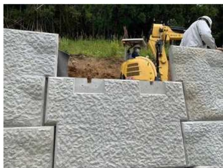
① 下側壁面材の設置
