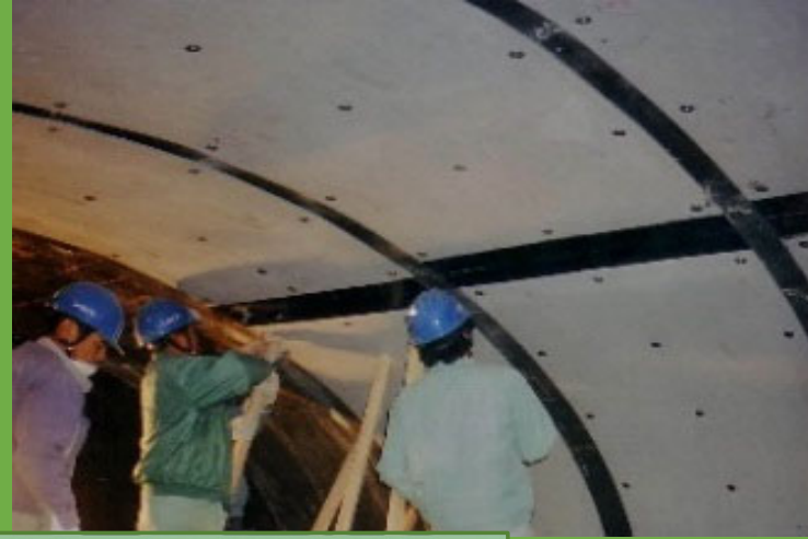
④ 充填材注入工・充填検査工
