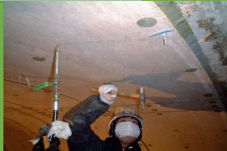
④ 充填材注入工・充填検査工
