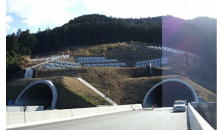
トンネル坑口の地すべり対策：新東名高速道
