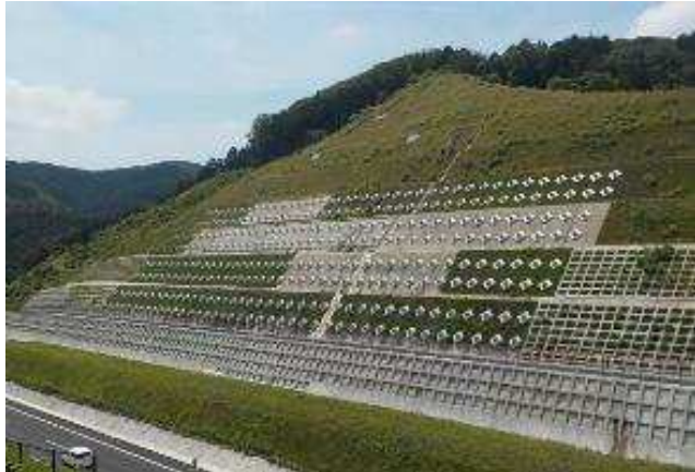
切土のり面：新東名高速道
