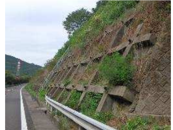
切土のり面：東海北陸道
