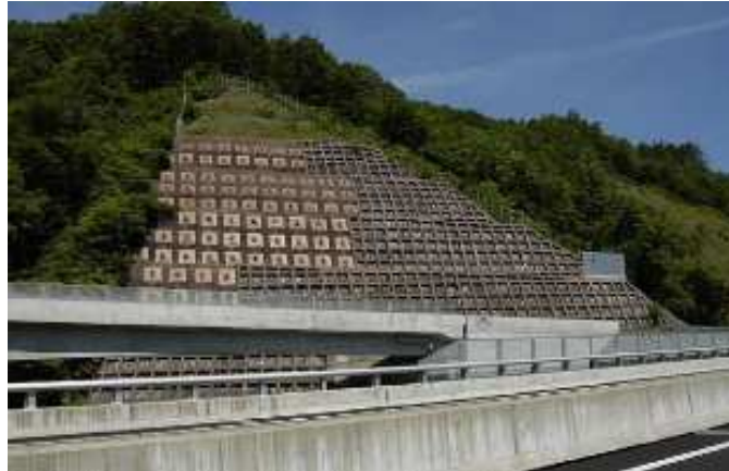
切土のり面：東海北陸道
