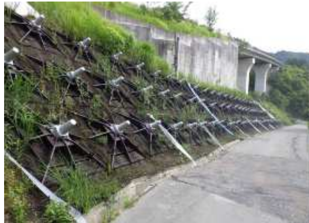
自然斜面の地すべり対策：紀勢道
