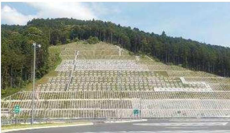
切土のり面：新東名高速道
