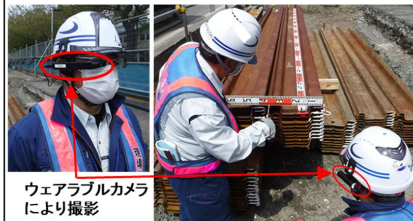
現場での受注者による撮影状況
