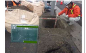
【試掘による確認】
