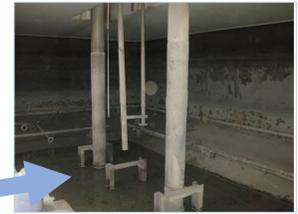
割れた既存の下地（FRP）もポリウレアを吹付けることによって構造物の長寿命化が実現します
