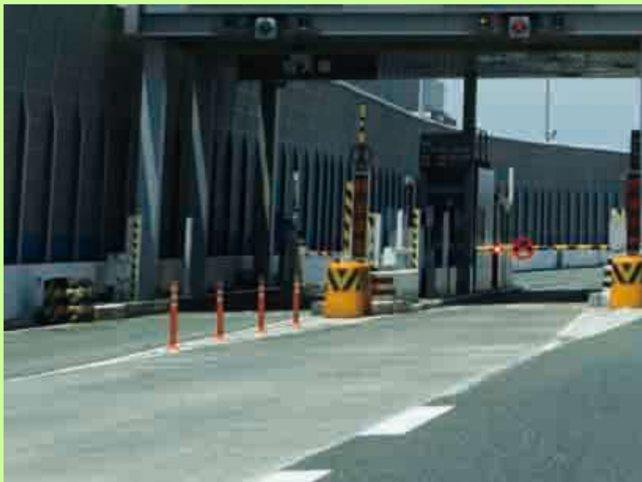
半たわみ性舗装（料金所）
