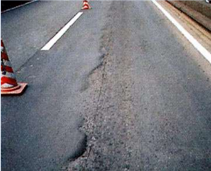
既設路面状況
