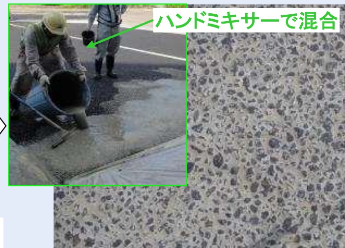
浸透用セメントミルクの製造
