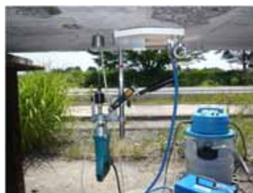
下面からの調査
