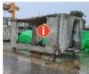
② i コンスペーサを設置しコンクリート打込み
