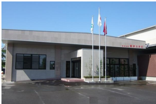
本社・中央試験室
