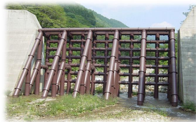
鋼製透過型堰堤
