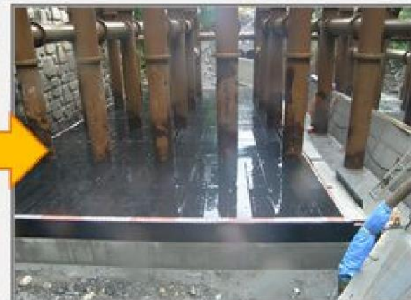
⑧出来形確認完成
