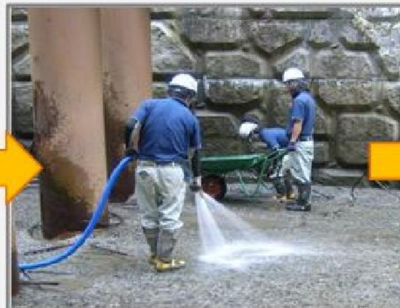
③鋼製堰堤内の土砂撤去、清掃
