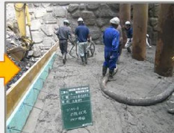
④コンクリート打設養生
