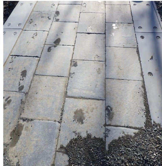
(④-1：張石の外観状況)
