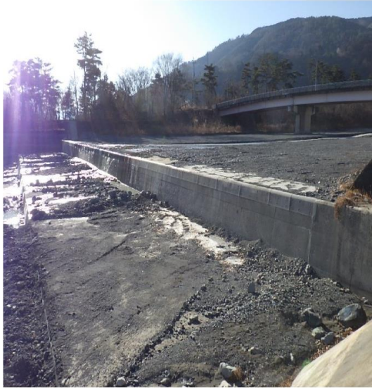
(全景：左岸下流側から望む)
