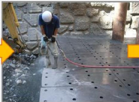
⑥エポキシ樹脂注入アンカーボルト打設
