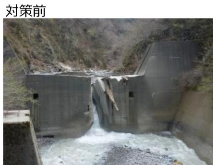
常時流水の影響による摩耗の進行
