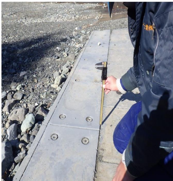
(⑦-2：中央側 垂直壁下流肩の摩耗量測定状況)
