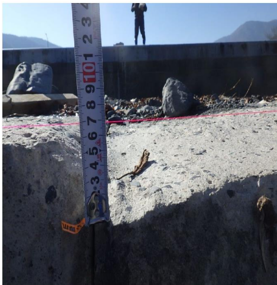
(⑦-2：中央側 垂直壁下流肩の摩耗量測定状況)
