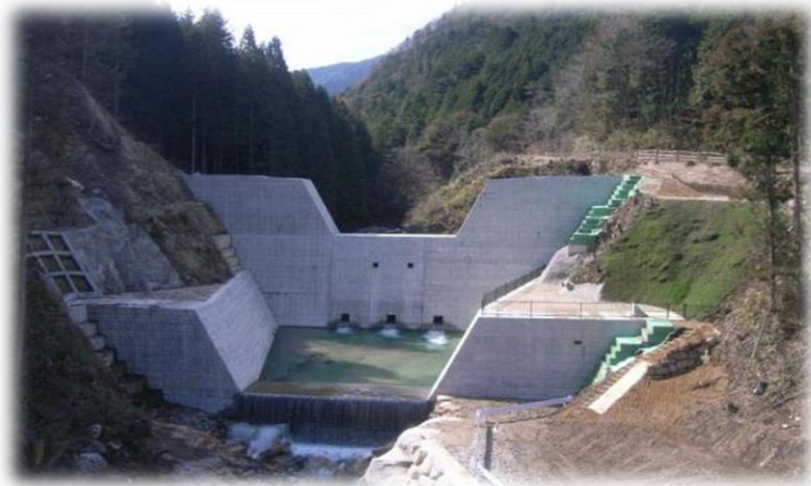
不透過型砂防堰堤
