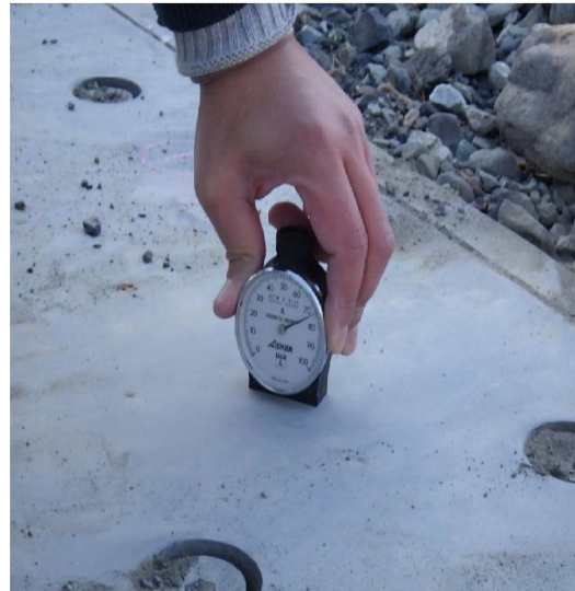
(③：ラバースチール硬度測定状況)
