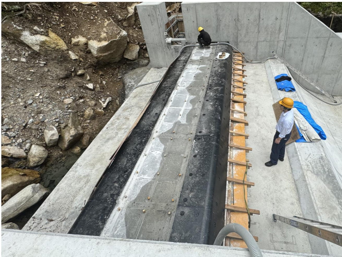
天端についてはボルトゲージと同様の施工方法
