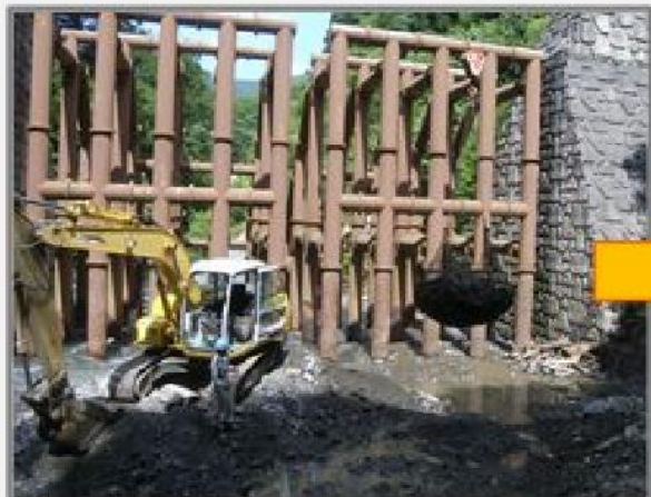
①堰堤上流側の流木、土砂の撤去
