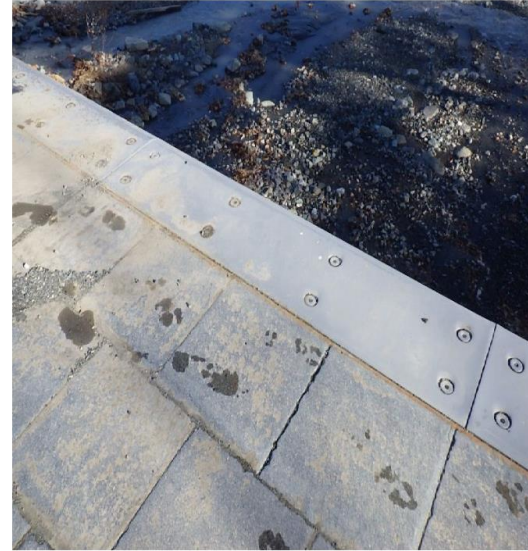
(①-2：ラバースチール下流肩天端の外観状況)
