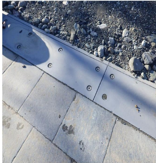
(①-1：ラバースチール上流肩天端の外観状況)
