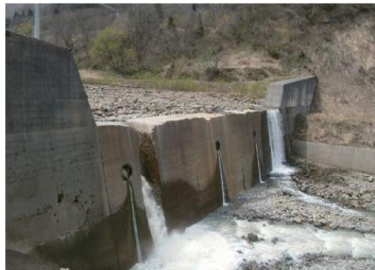
▲ラバーSteel設置なし (経過年数10年※コンクリートにて天端補修後 最大約10mの摩耗) (位置：右記砂防堰堤の下流)
