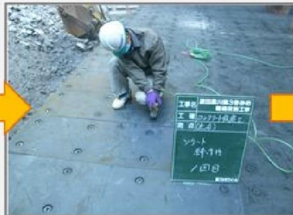
⑦固定ボルト締め付け
