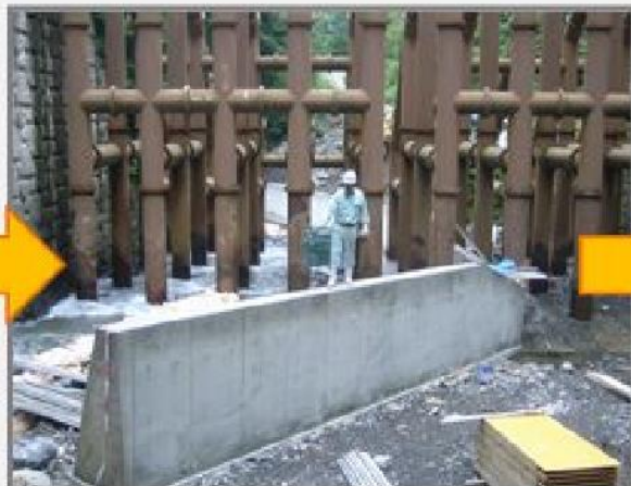
②仮設工の設置(半川締め切り)
