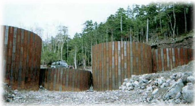
鋼製セル堰堤
