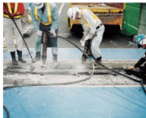
②箱抜き部処理(研り)
