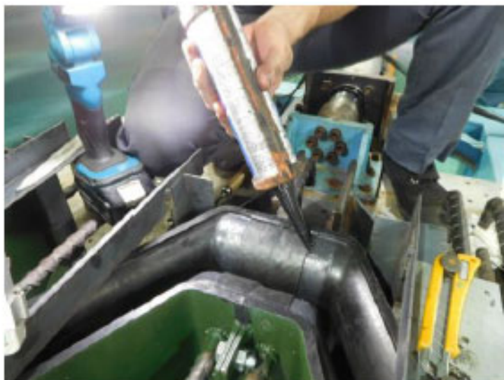
接合部仕上げ
