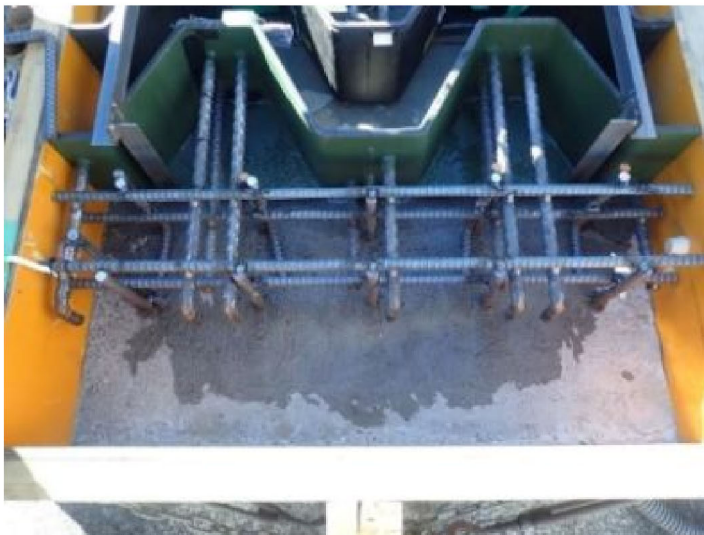
溶接後の状況
