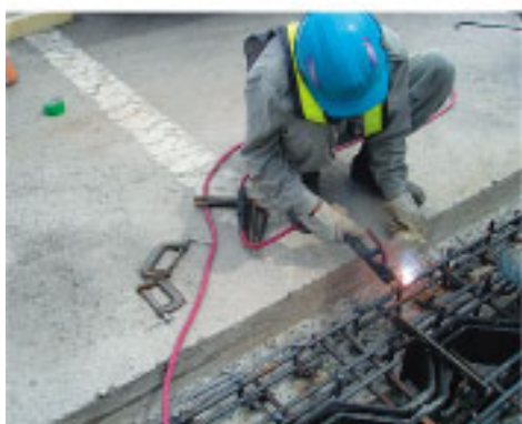
⑤取付・溶接
