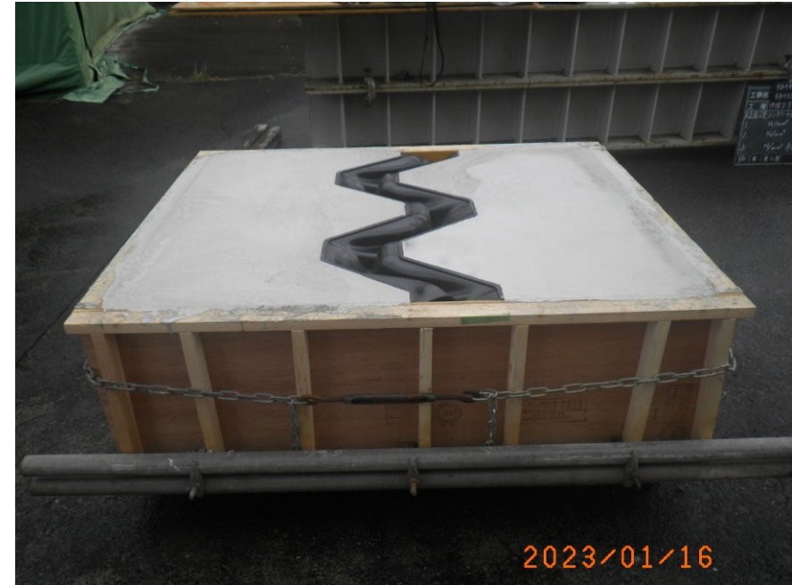
コンクリート打設完了
