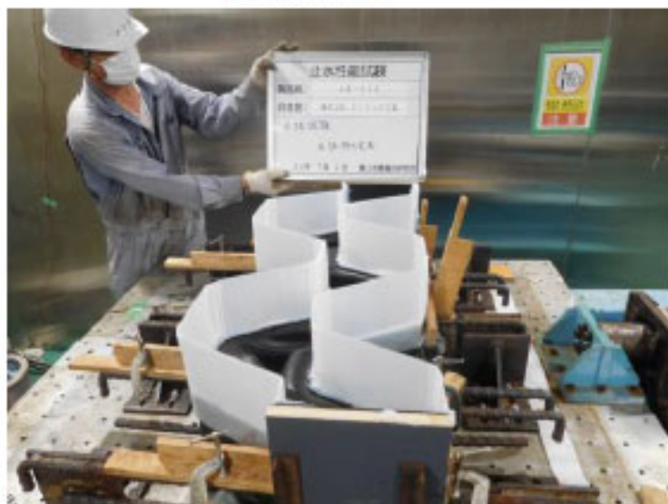
水張枠作製完了 (側面)
