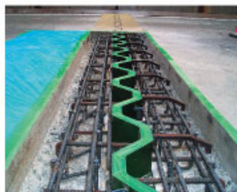
⑥取付完了 (コンクリート打設前/ガムテープで養生)
