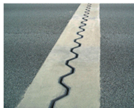
⑧施工完了
