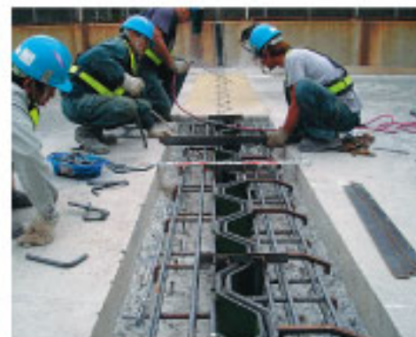
④レベル出し・直線性出し・固定
