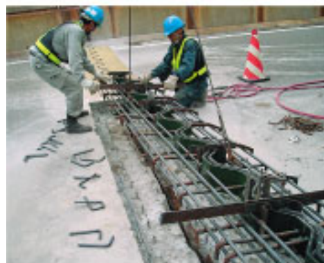
③一車線組立品の吊り下ろし・配置
