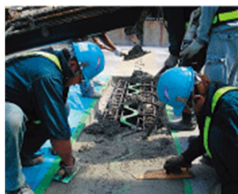
⑦コンクリート打設
