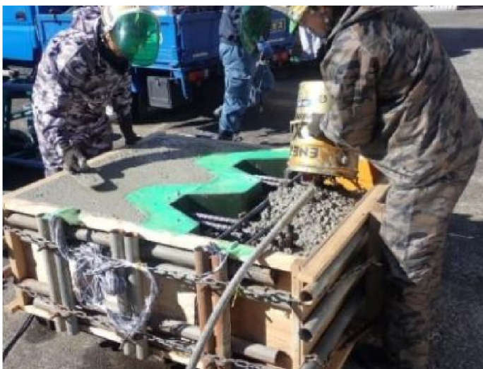
2次コンクリート打設状況
