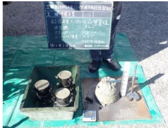
2次コンクリートの品質管理
