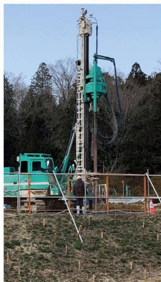
盛土法肩での施工実験
