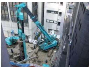
狭隘地での施工(ビル街・住宅地内など)
