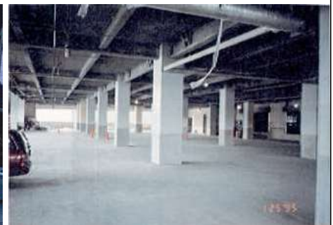
TOFT工法を適用したホテル内部
