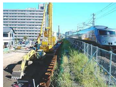
狭隘地での施工(営業線近接)
