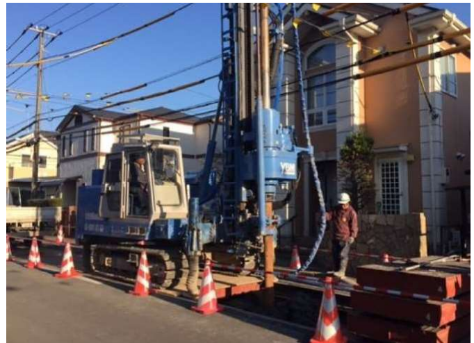
住宅地内の地盤改良状況(千葉県浦安市)
