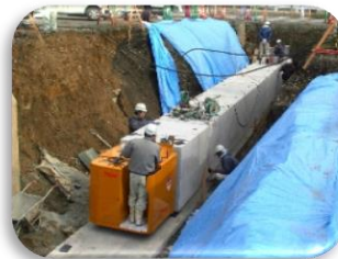
据え付け状況
