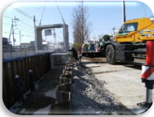
据え付け状況
