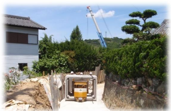
住宅密集地への適用例 (水路) 内幅1600×1300
