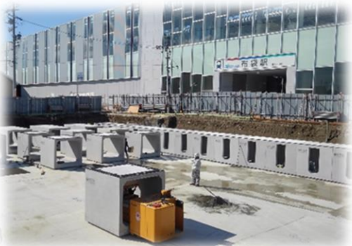
新ボックス型アグアへの適用例 (雨水貯溜槽) 1630m 3 (内幅1800×内高1500)
