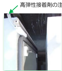
上面から下方を見る
