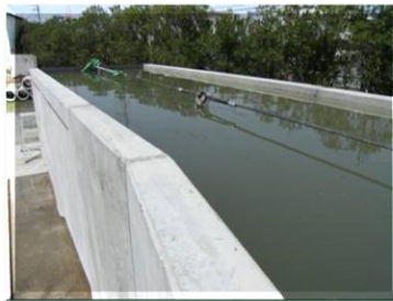
変位後の漏水なし
