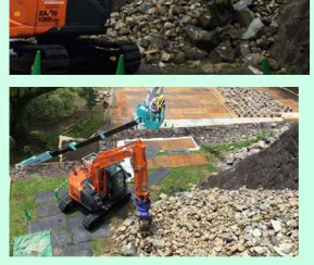
熊本城飯田丸五階櫓石垣復旧工事(熊本地震災害)(H29.3~H29.7)
