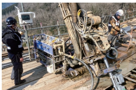
削孔角度方位計測状況
