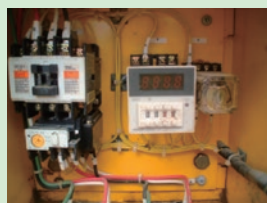
従来型水量計の調整箇所
