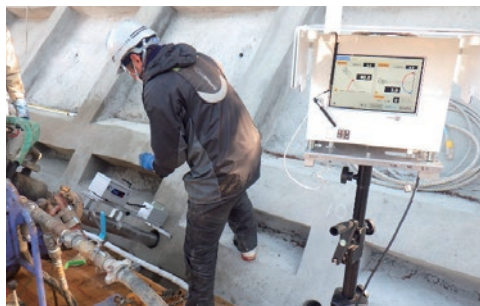
削孔角度方位計測状況
