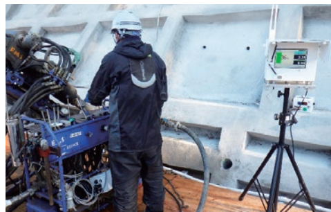
削孔長計測状況
