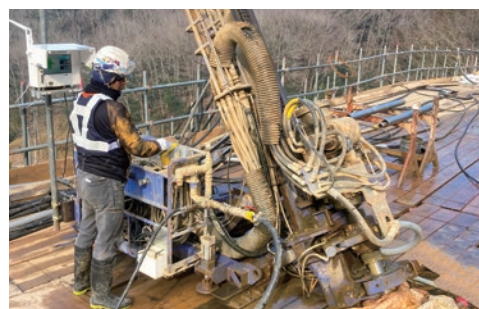
削孔長計測状況
