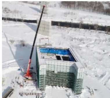
プレキャスト部材の活用
