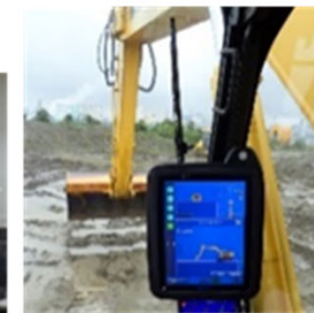
ICT建設機械の施工
