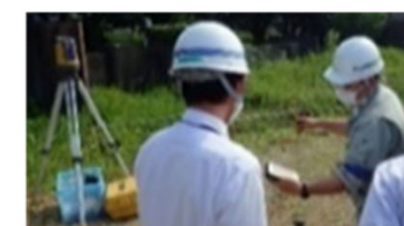
トータルステーション計測
