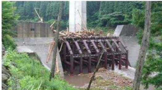
透過型砂防堰堤(熊本県小国町)
