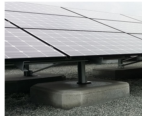
山口県 太陽光発電パネルの基礎
