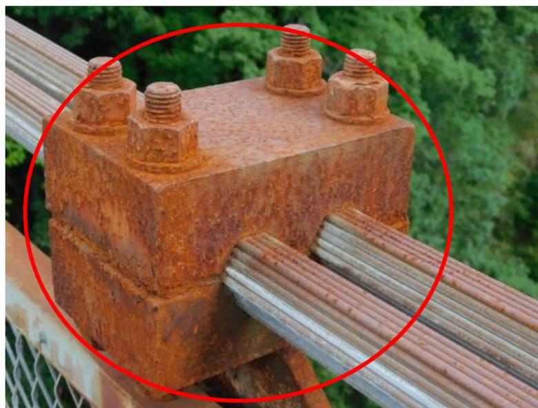
主ケーブル、ケーブルバンドの腐食状態
