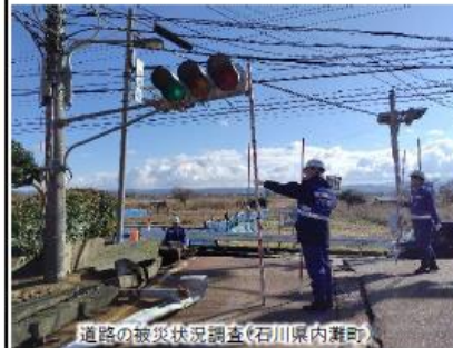
道路の被災状況調査(石川県内野町)
