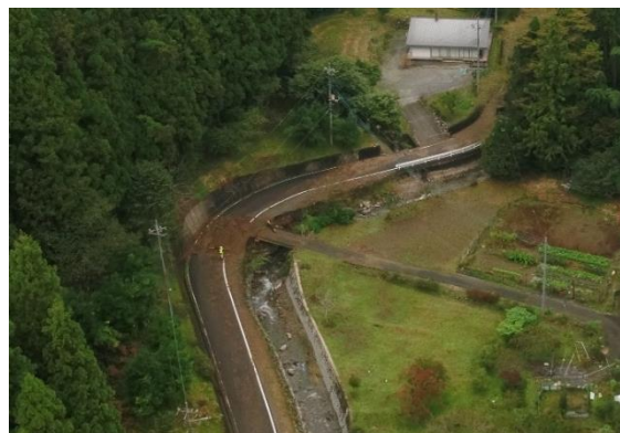
道路の被災状況調査 (栃木県栃木市)
