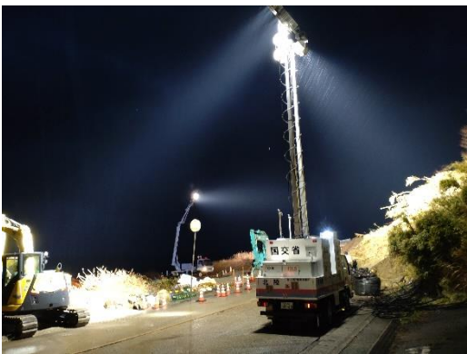
輪島市内での照明車派遣状況
