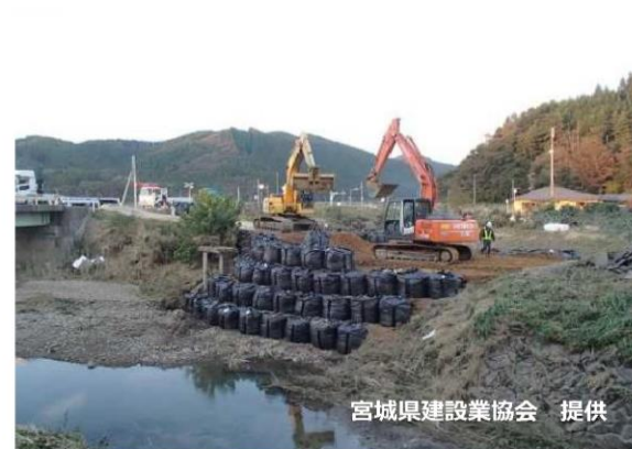
宮城県建設業協会員による河川堤防緊急応急 (台風19号 宮城県津山町)
