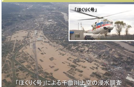
【令和元年東日本台風】 (長野県長野市上空)
