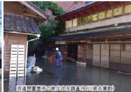
河道閉塞箇所等の被災状況調査(石川県志賀町)
