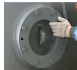
既設ポンプの点検窓枠
