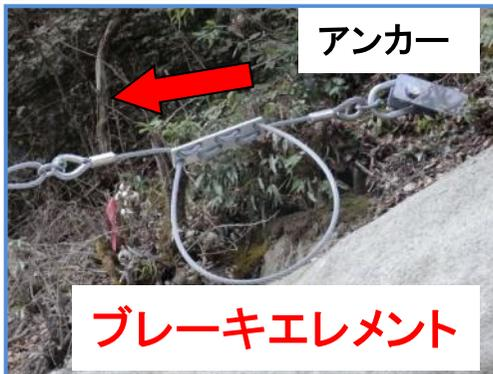
落石捕捉時には**ブレーキエレメント**が伸びることでエネルギーを吸収する。
