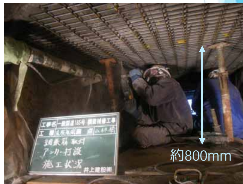
塩害劣化・鉄筋欠損：小林橋(RC床版橋：広島県) 2010年 3月
