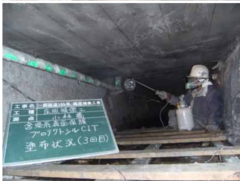
塩害劣化・鉄筋欠損：小林橋(RC床版橋：広島県) 2010年 3月
