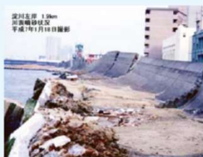
地震による堤防の被災
