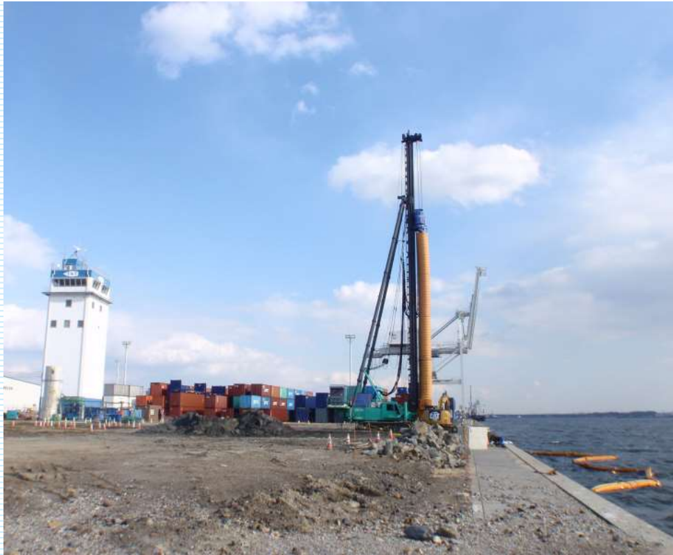
工事中の三河港神野地区岸壁
