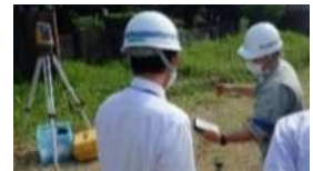
トータルステーション計測
