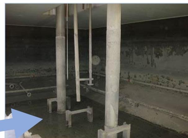
割れた既存の下地（FRP）もポリウレアを吹付けることによって構造物の長寿命化が実現します
