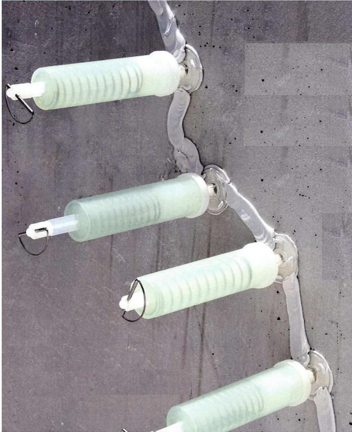
便宜上、IPH工法は低圧樹脂注入のジャンルに区分されていますが、**他の注入工法とはその目的が全く違います。**
