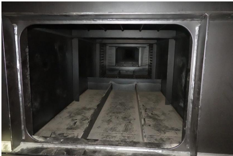
橋梁箱桁内部
