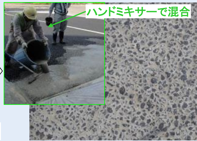
浸透用セメントミルクの製造
