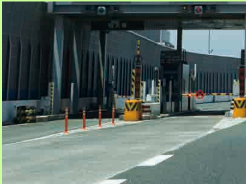
半たわみ性舗装(料金所)
