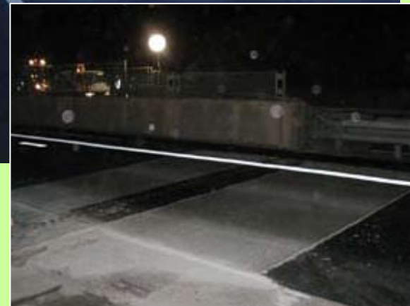
ジョイント保護工
