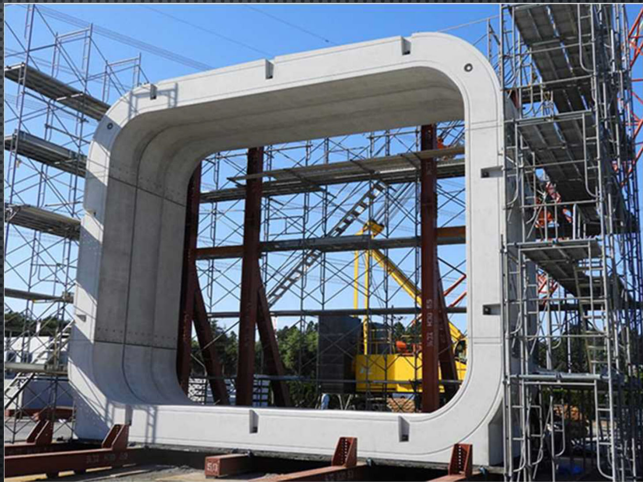
※工場内組立試験状況
