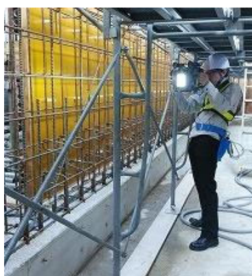
開削トンネル
