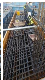
スターラップで2本分を計測 斜角鉄筋
