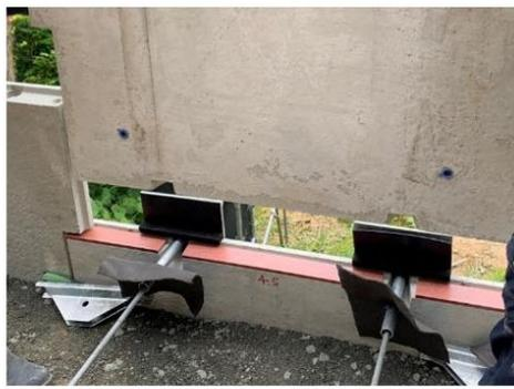
⑦ 上側壁面材の設置、固定
