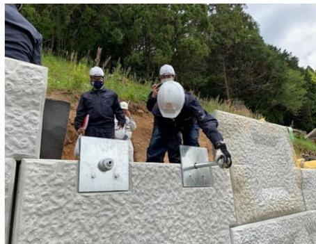
③ 支圧板類を壁面材前面に取付け
