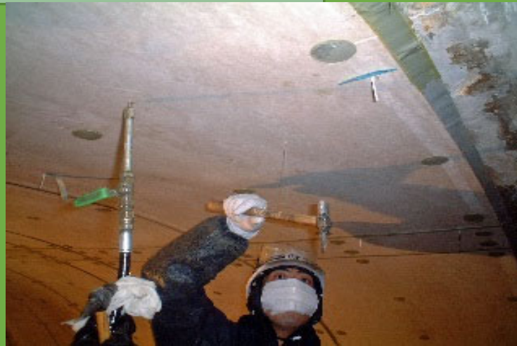
④ 充填材注入工・充填検査工
