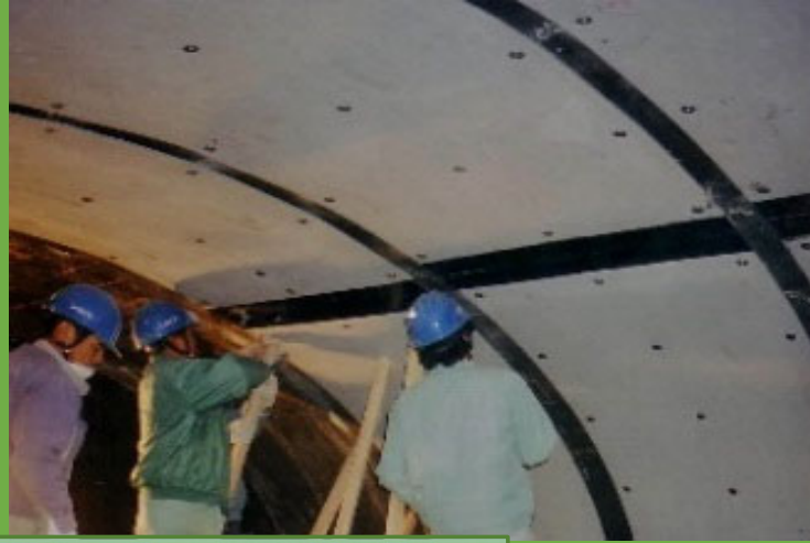
④ 充填材注入工・充填検査工
