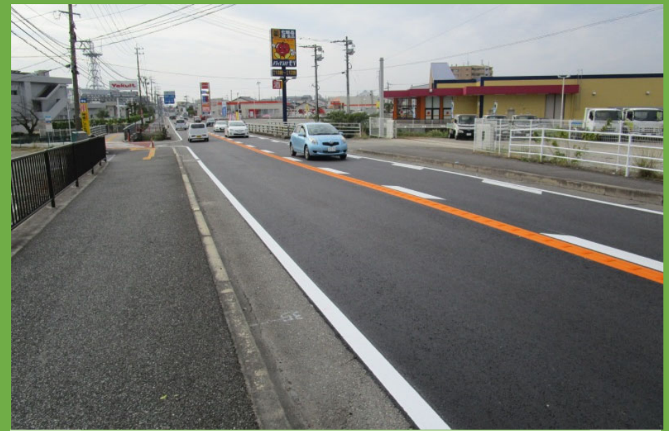
After (リラックスファルト舗装)
