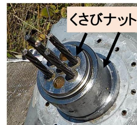
※リフトオフ試験の比較数が少ないのは、過緊張でリフトオフ試験を中止したアンカー(2本)があるためである。
