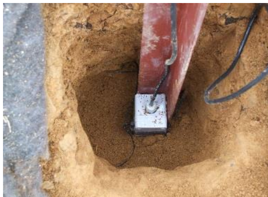
センサーモジュールの設置(地中埋設)
