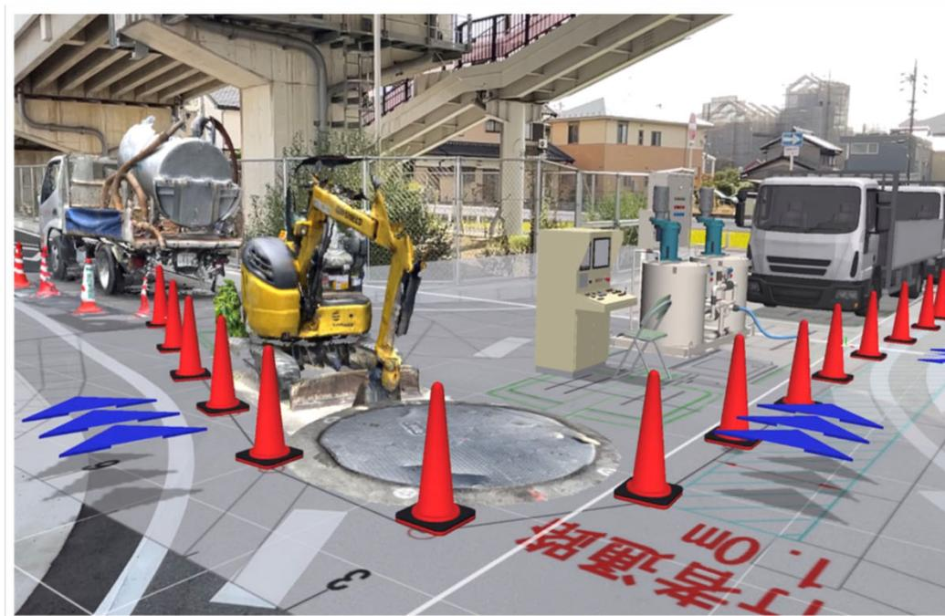
施工前の場所にあらかじめ設計した**3Dモデル**を配置し、**配置検討**が可能。
