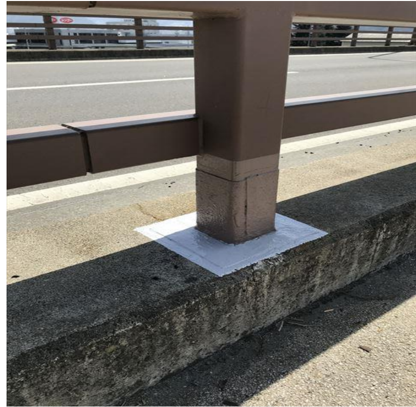
NEac + Q-SET施工完了
