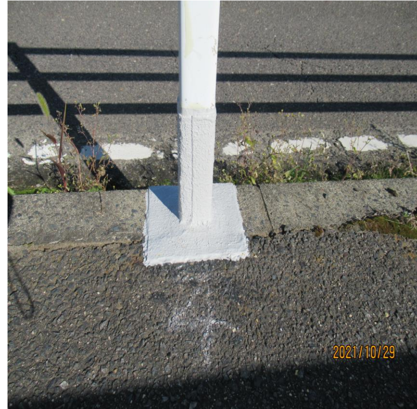
NEac + Q-SET施工完了
