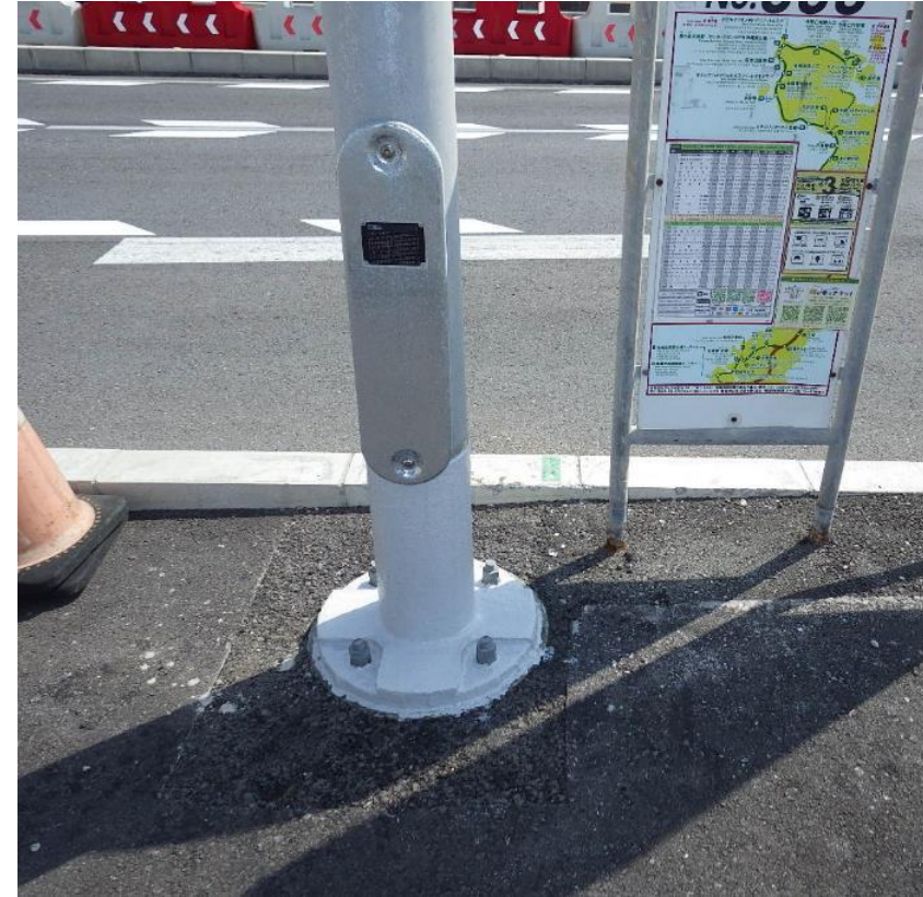
NEac + Q-SET施工完了
