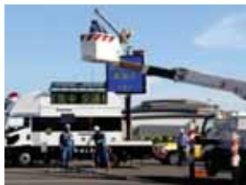
■倒壊電柱・電線の除却訓練
