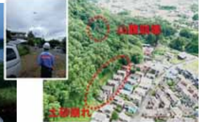
ドローンによる被災状況調査の状況 (ときがわ町関堀地区)
