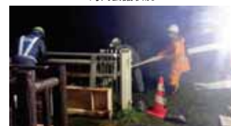
三郷排水機場における作業状況
