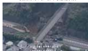
あおぞら号飛行調査状況(国道16号)
