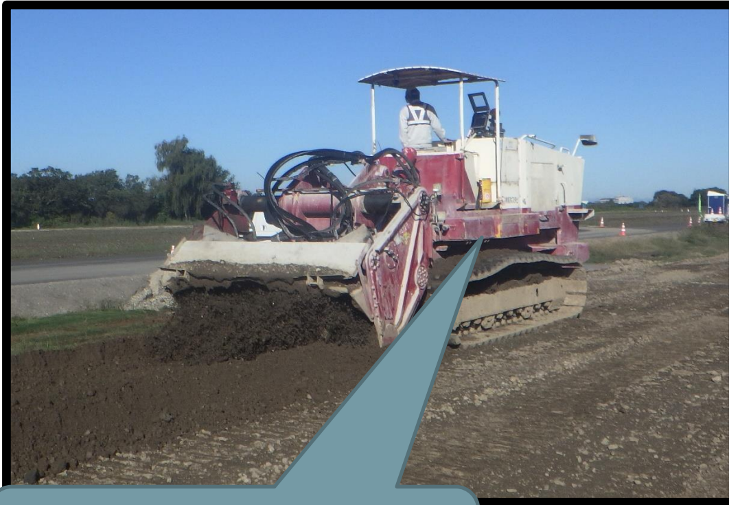
3次元GNSS施工管理システムを 搭載したスタビライザ
