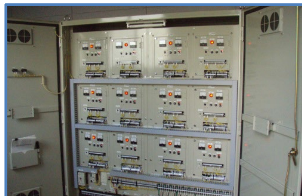
直流電源装置設置工
