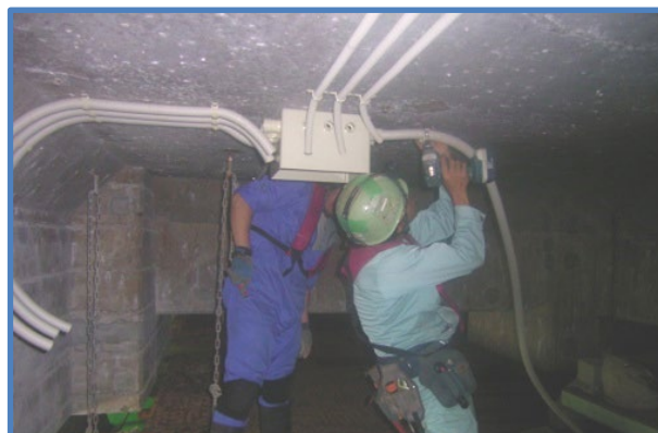
配線・配管工
