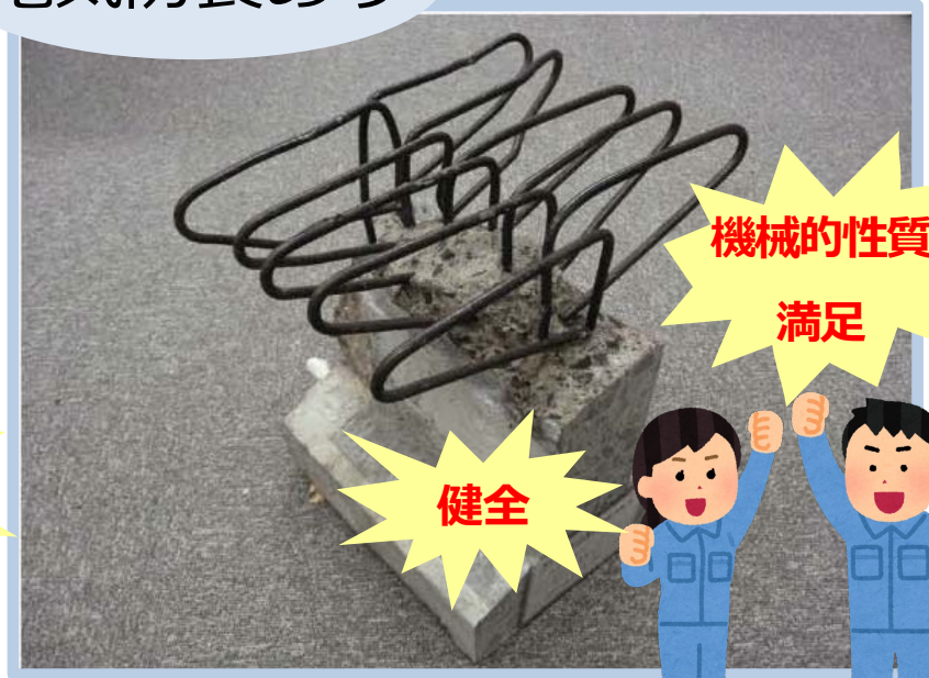
電気防食あり
