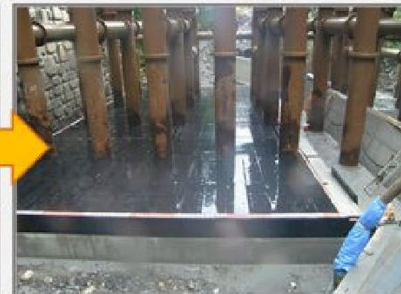
⑧出来形確認完成
