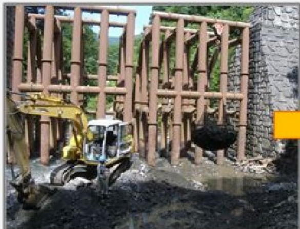
①堰堤上流側の流木、土砂の撤去
