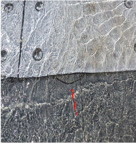
(⑦-1：右岸側 垂直壁下流肩の摩耗量測定状況)
