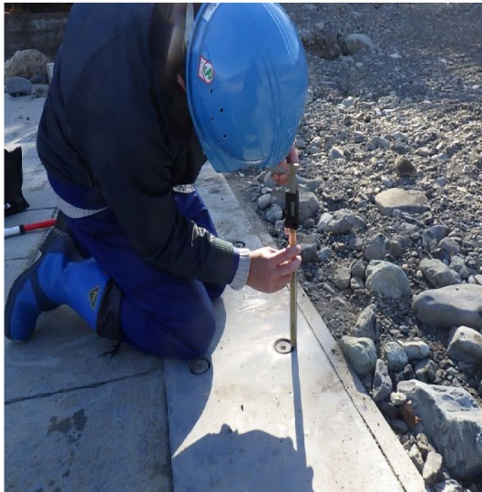
(②：ラバースチール摩耗量測定状況)
