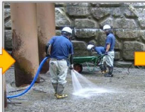
③鋼製堰堤内の土砂撤去、清掃
