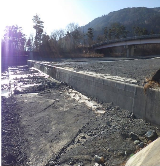
(全景：左岸下流側から望む)
