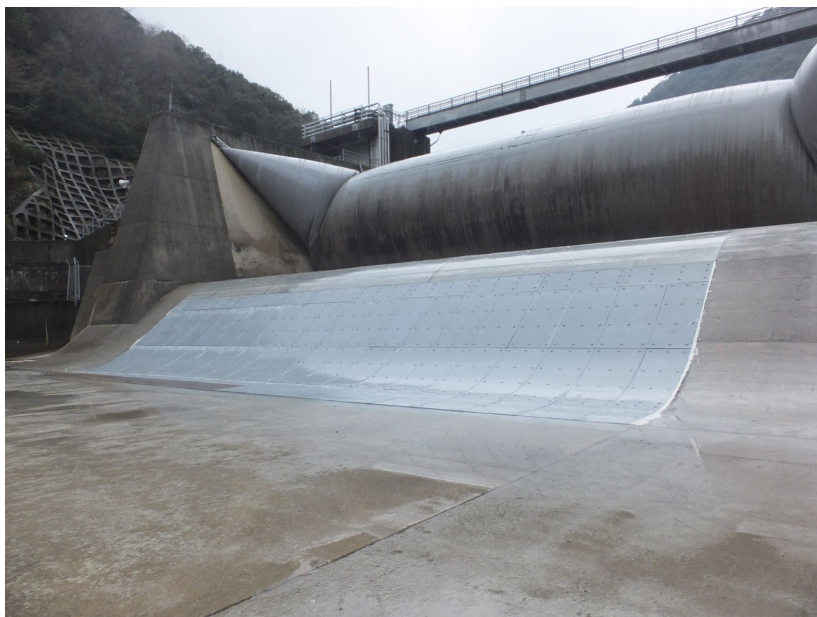
川辺川第一発電所
