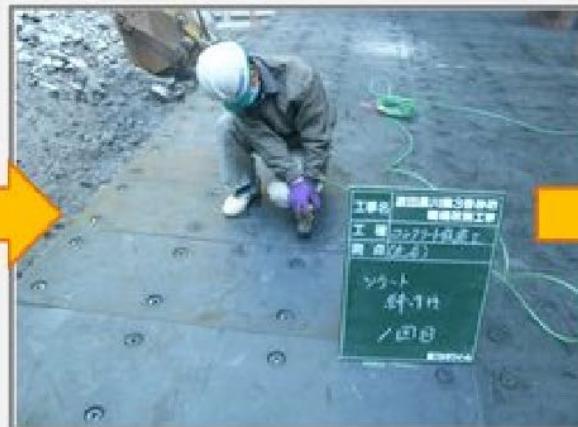
⑦固定ボルト締め付け
