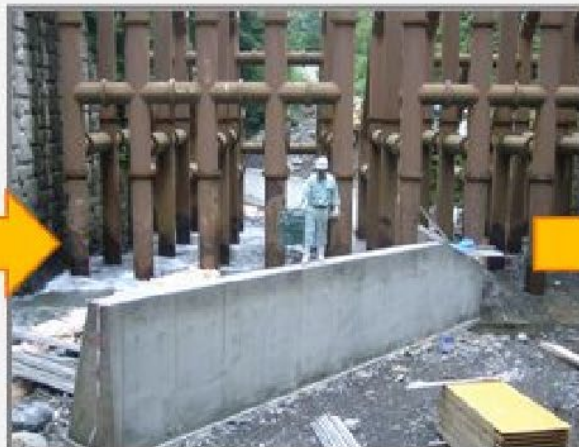
②仮設工の設置(半川締め切り)
