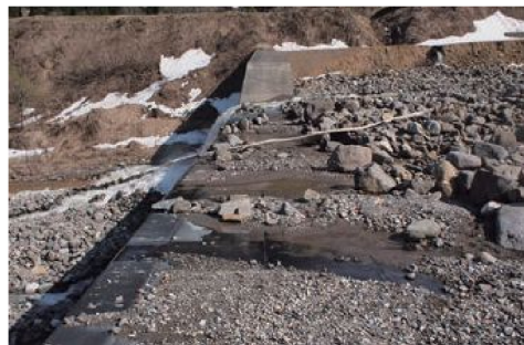
▲ラバーSteel設置状況 (平均摩耗速度0.26mm/年、経過年数18年時)
