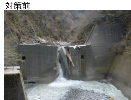
常時流水の影響による摩耗の進行
