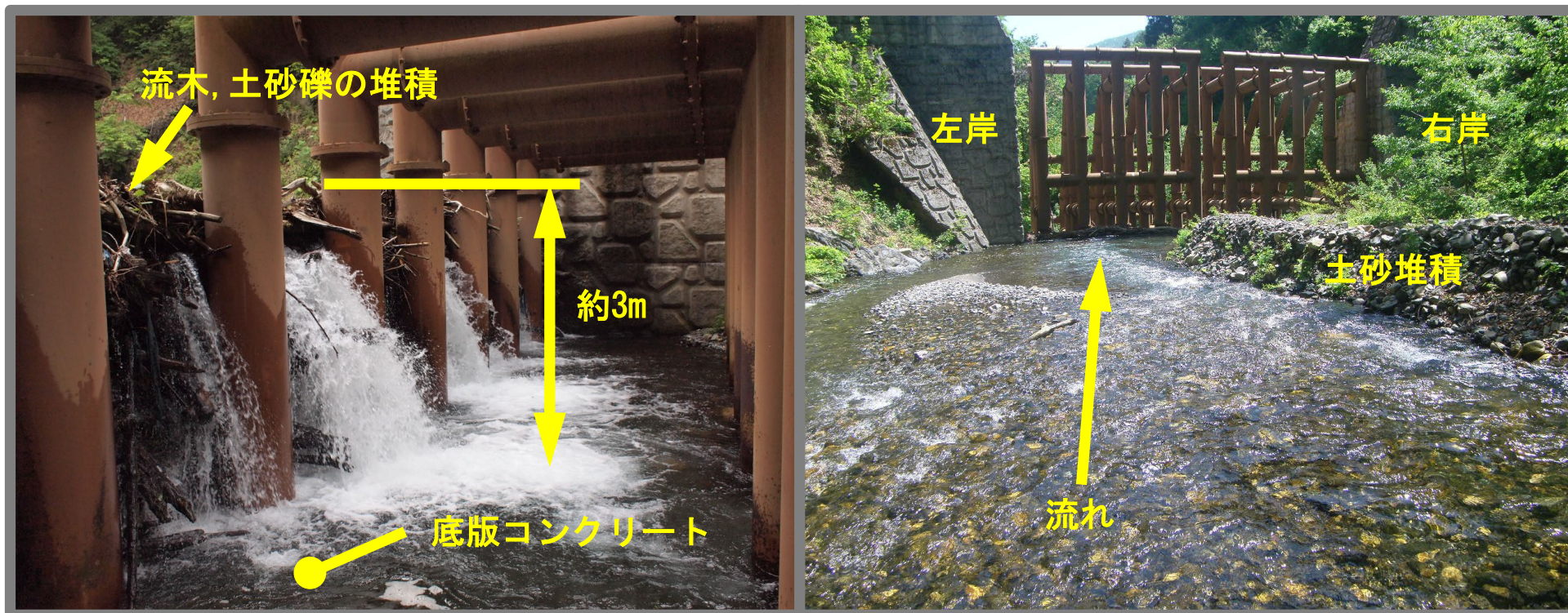
コンクリート補修前の鋼製透過型砂防堰堤の状況
