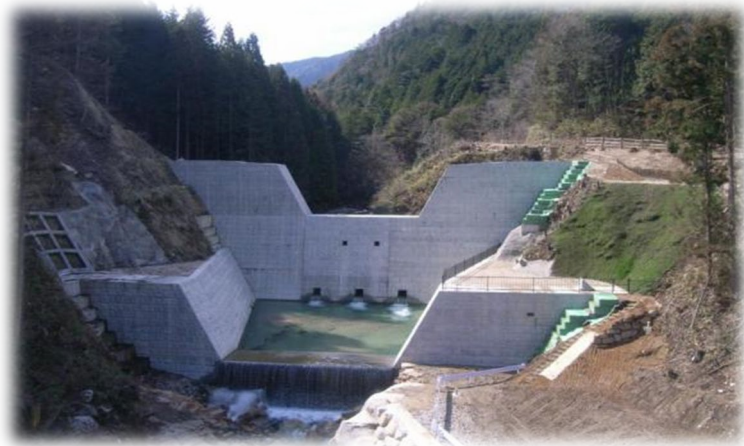
不透過型砂防堰堤
