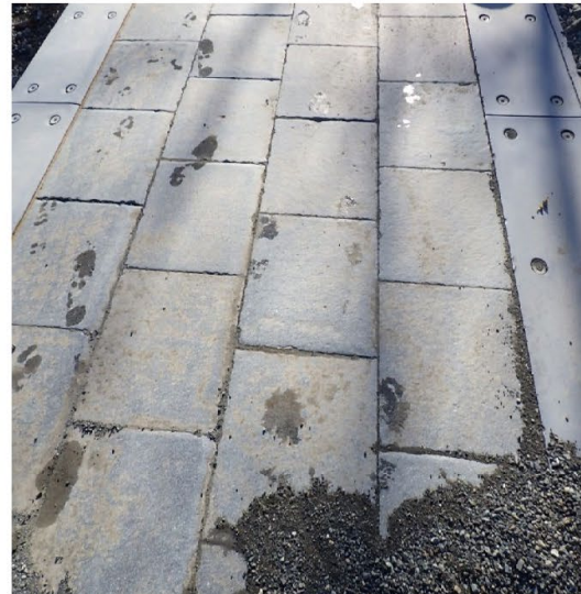
(④-1：張石の外観状況)
