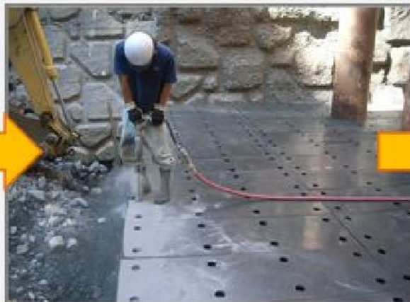
⑥エポキシ樹脂注入アンカー打設
