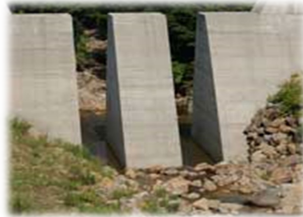
CONスリット堰堤
