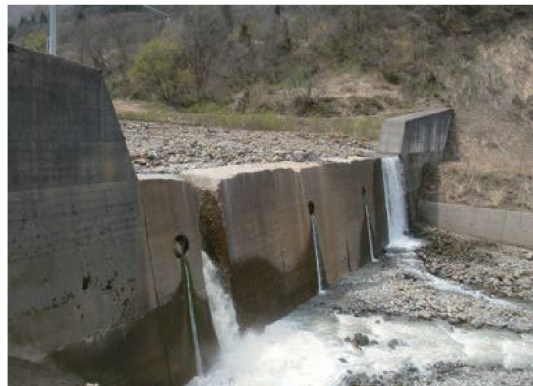
▲ラバーSteel設置なし (経過年数10年※コンクリートにて天端補修後 最大約10mの摩耗) (位置：右記砂防堰堤の下流)
