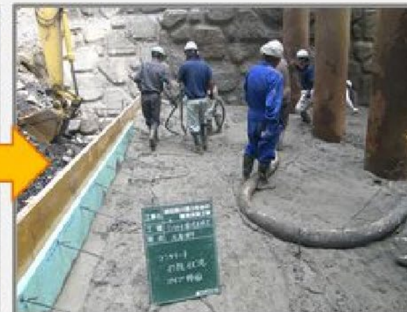
④コンクリート打設養生
