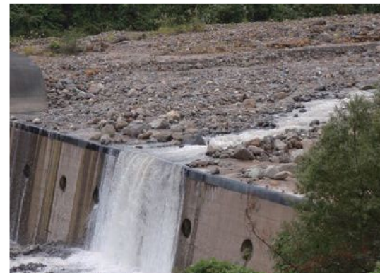
▲ラバーSteel設置あり(経過年数18年) (位置：左記砂防堰堤の上流) 下流のコンクリート製砂防堰堤が、10年で最大約10mの摩耗を受ける環境下でもラバーSteelは健全に機能しています。
