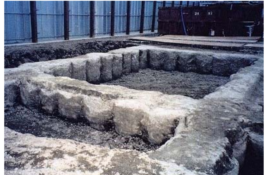
掘出し調査による出来型の確認状況
