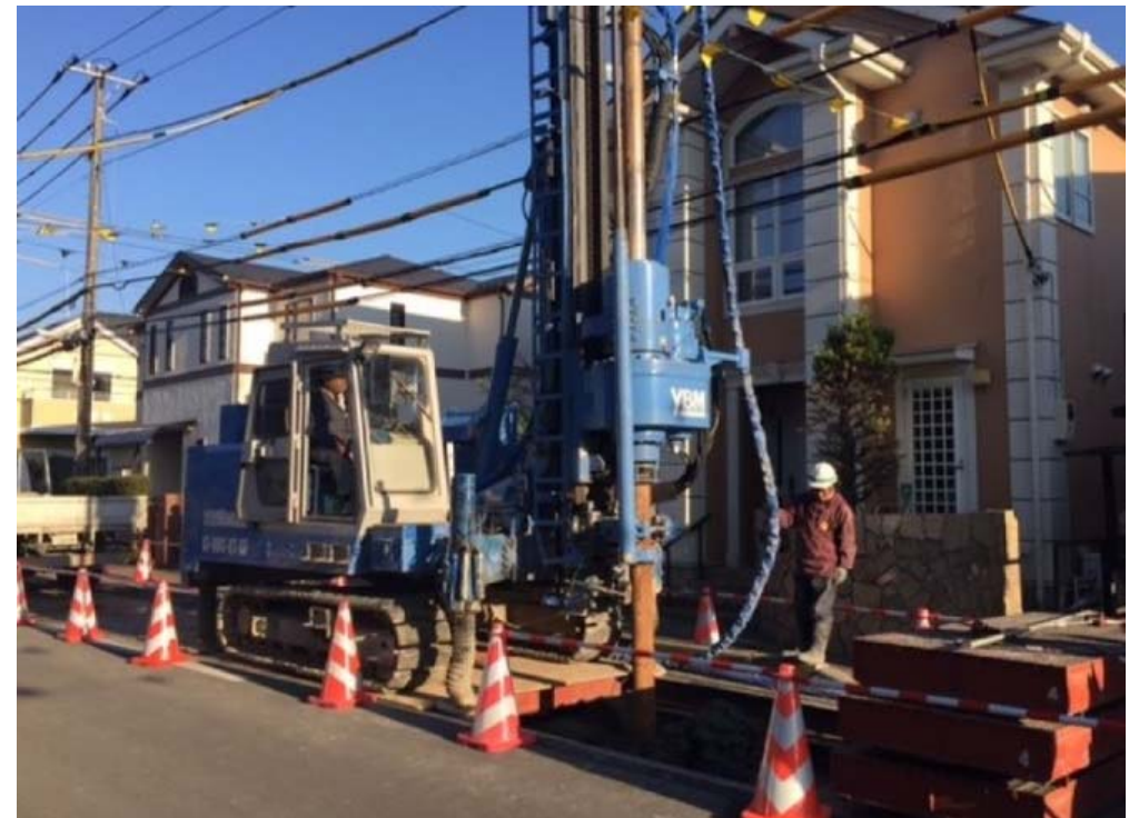
住宅地内の地盤改良状況(千葉県浦安市)
