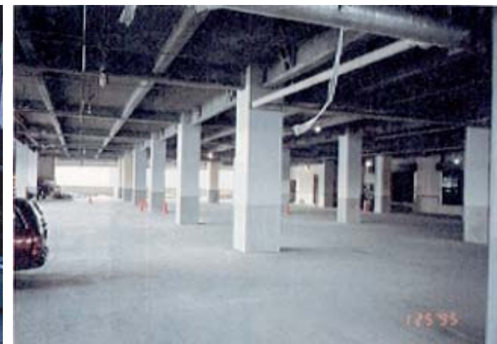
TOFT工法を適用したホテル内部
