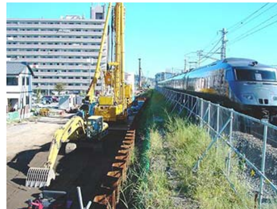
狭隘地での施工（営業線近接）
