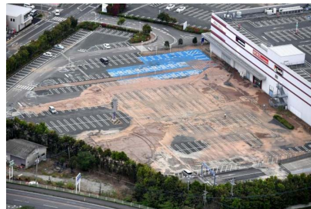
熊本地震 液状化被害
