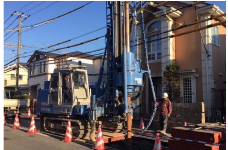
実際の施工状況(千葉県浦安市の住宅地)
