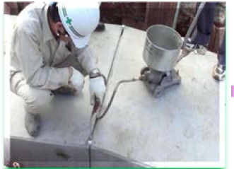
注入口より側壁部・底版部へ注入
