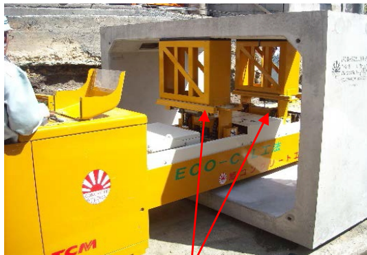
リフトアップ部
