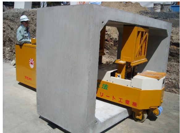
【ECO-C・L工法による搬送・据付】
