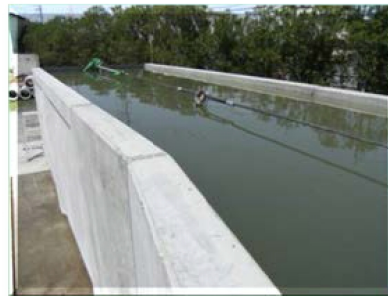
変位後の漏水なし
