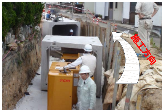
急曲線での施工状況
