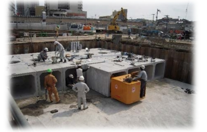
BOX型雨水貯溜槽への適用例 内幅1200×内高1200mm (ボックスどうしは耐震接続「TB(タッチボンド)工法」)
