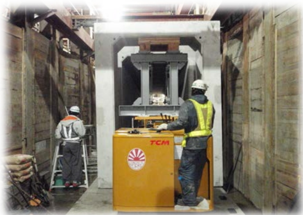
縦長製品への適用例 (共同溝) 内幅1700×内高2700
