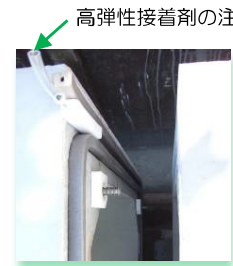
上面から下方を見る
