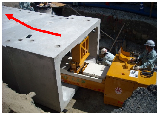
斜型製品の据え付け状況
