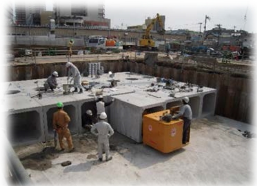
BOX型雨水貯溜槽への適用例 内幅1200×内高1200mm (ボックス同士は耐震接続「TB(タッチボンド)工法」)
