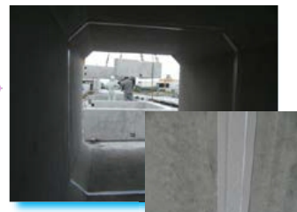
内部の状況 曲線部も直線部と同じ施工！
