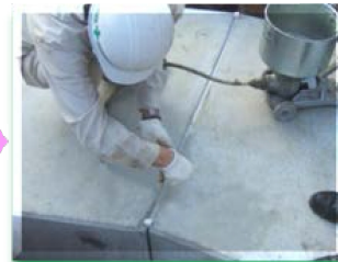
上部より頂版天端部へ注入
