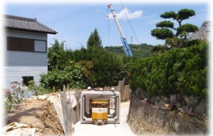
住宅密集地への適用例 (水路) 内幅1600×1300
