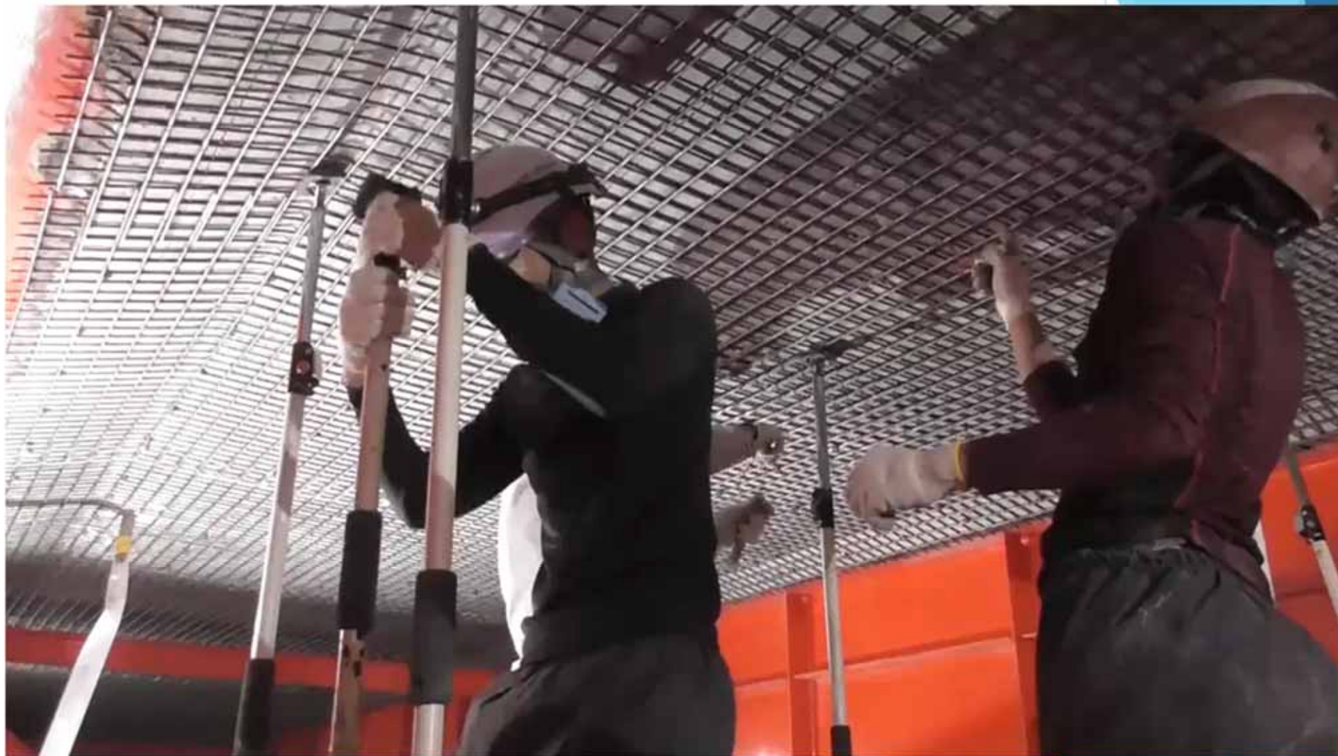
格子状溶接鉄筋 固定状況
