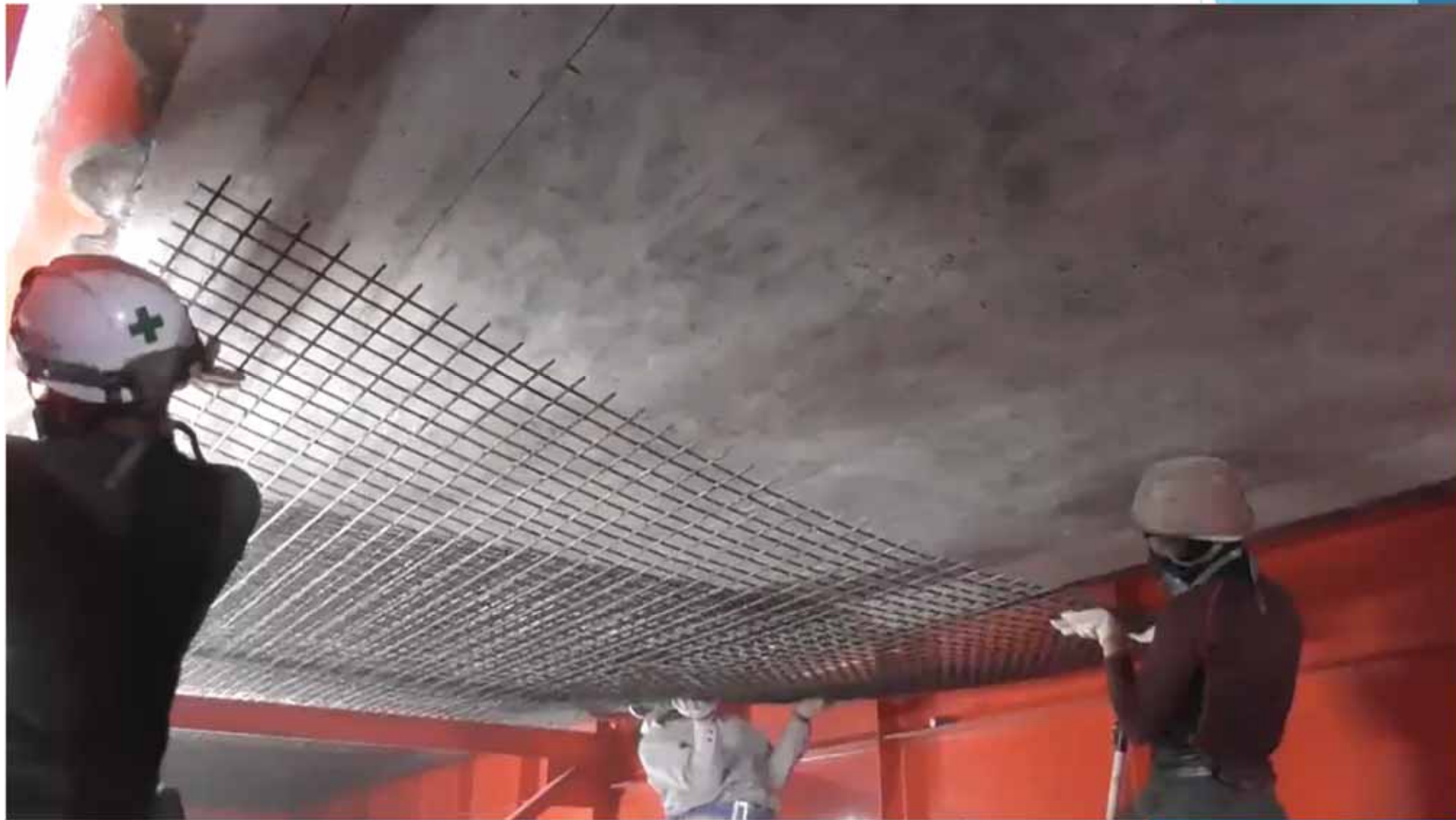
格子状溶接鉄筋 固定状況
