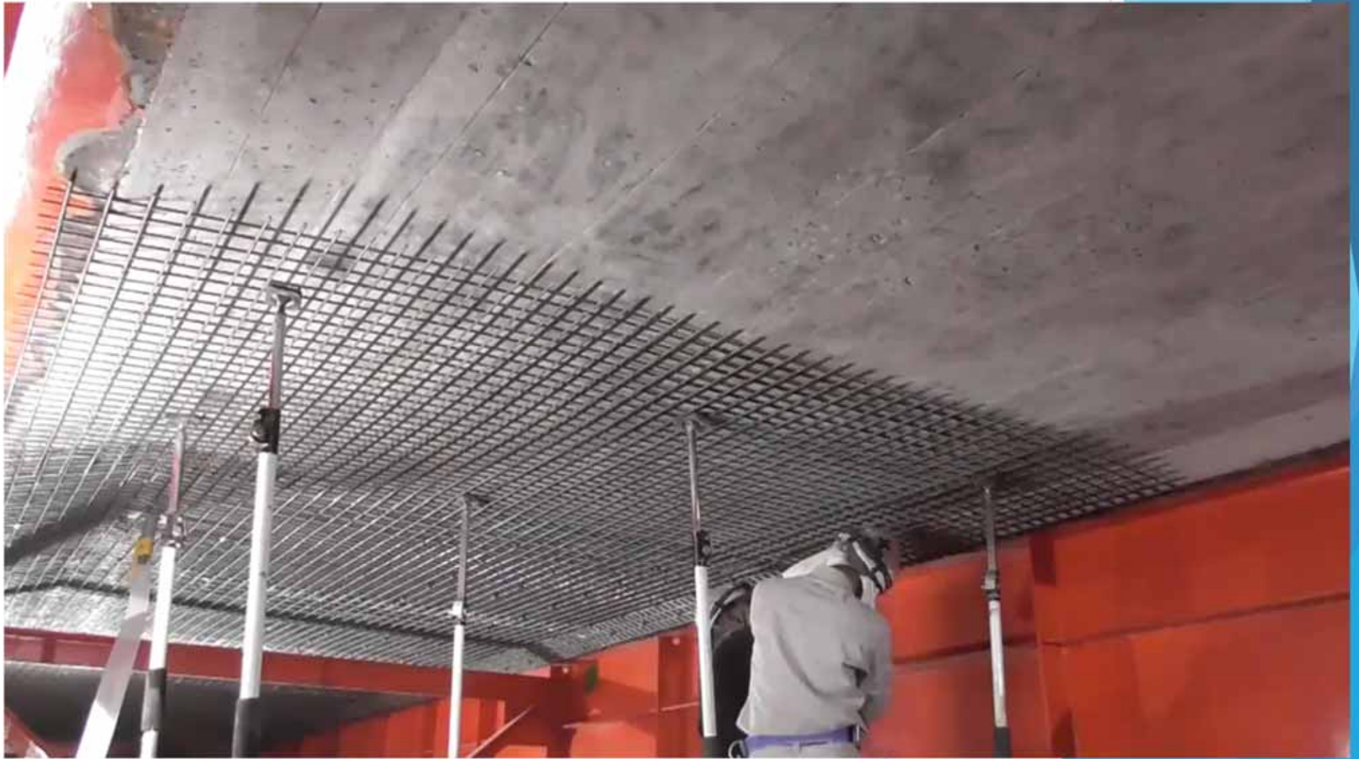
格子状溶接鉄筋 固定状況
