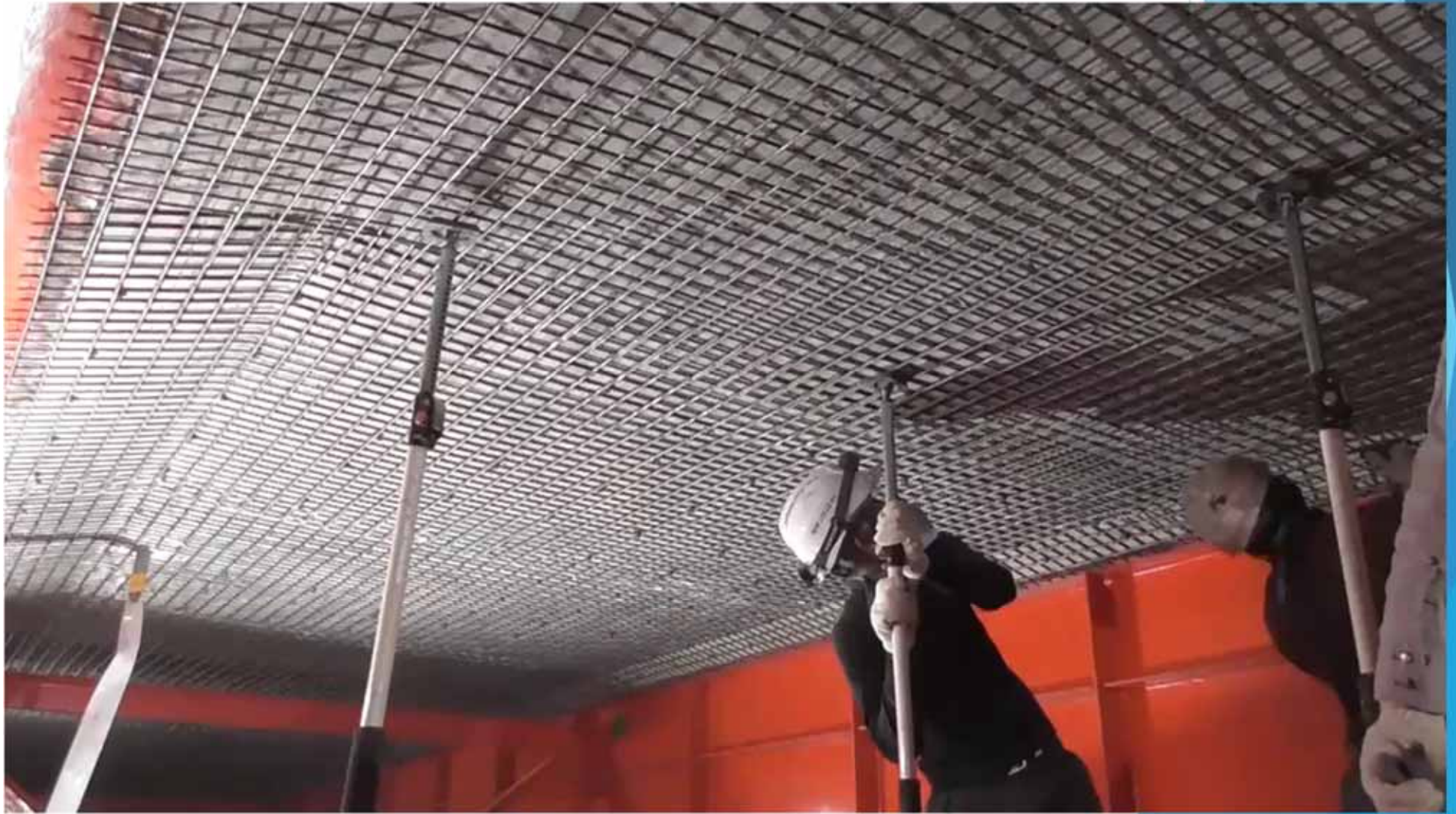
格子状溶接鉄筋 固定状況
