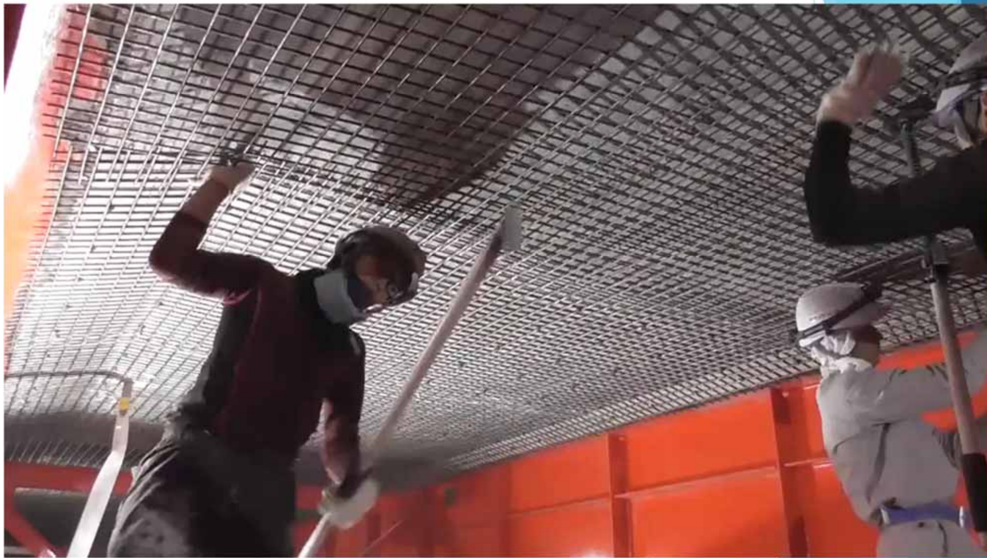
格子状溶接鉄筋 固定状況
