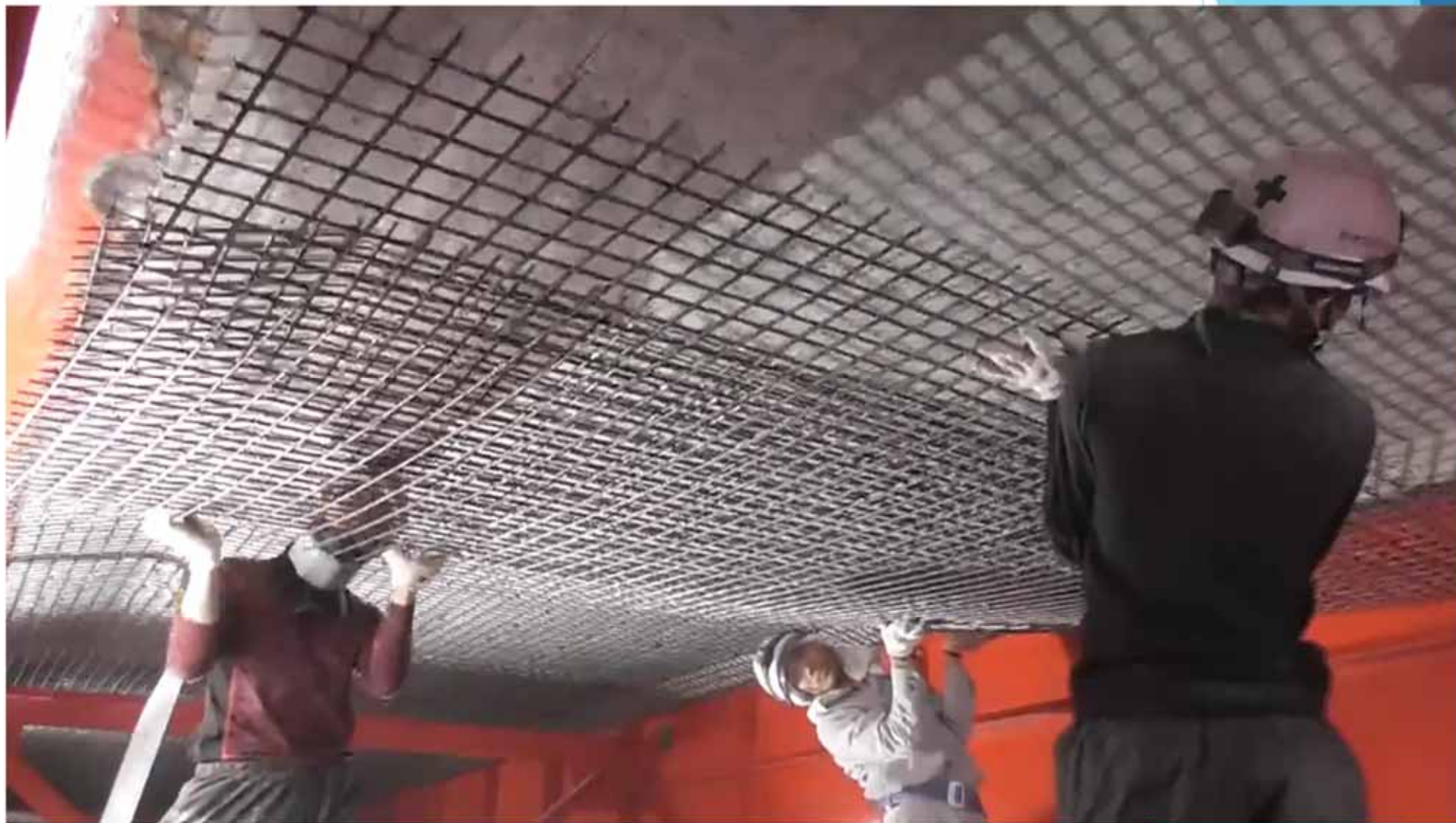
格子状溶接鉄筋 固定状況
