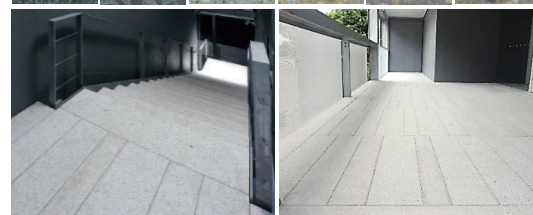
外階段、エントランスへの適用
