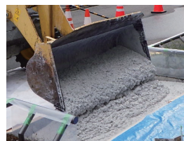
現場打ち舗装施工状況
