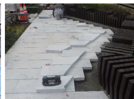
舗装ブロック施工状況
