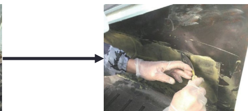
シート 貼付け (貼付けプライマー使用)
