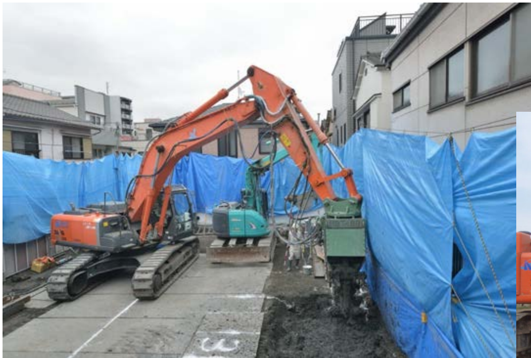
【建物近接施工】
