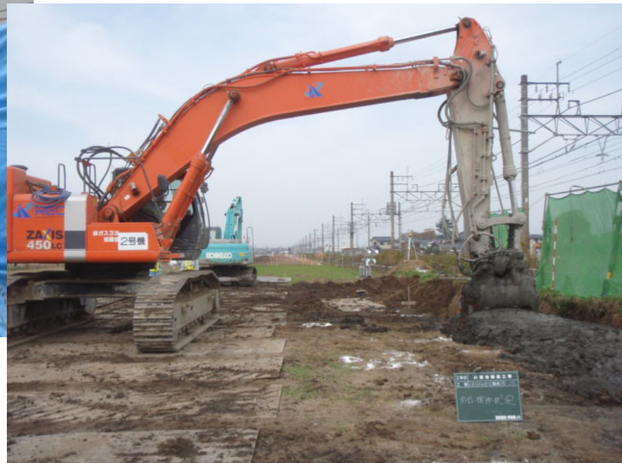
【鉄道近接施工】
